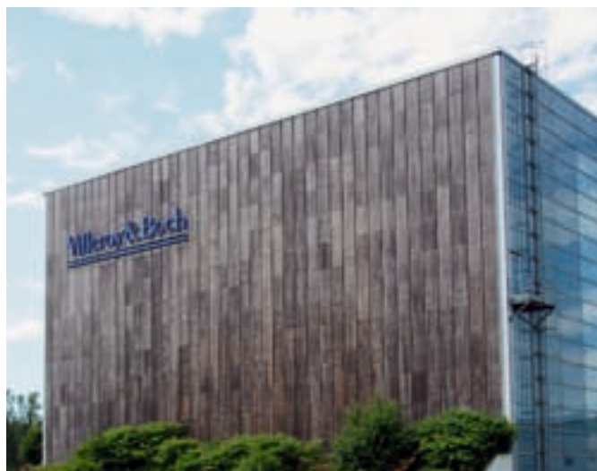
GEWERBEBAU VILLEROY & BOCH, KERTO-FASSADE, KESSELDROCKIMPRÄGNIERT
