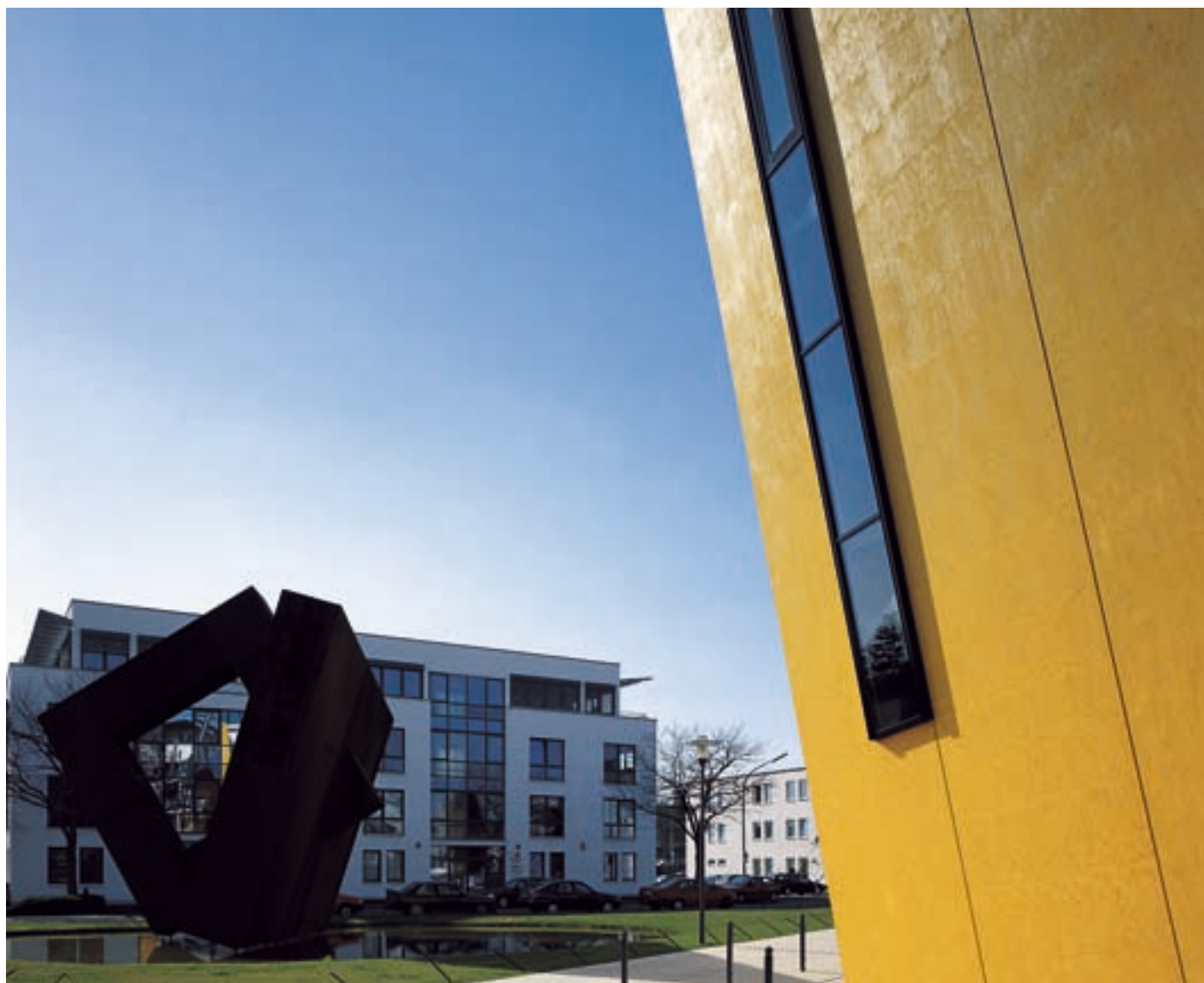
KERTO-FASSADE „FACHHOCHSCHULE JÜLICH“
